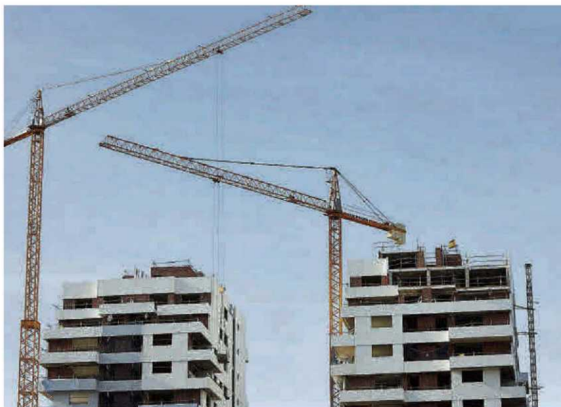
Pisos en construcción en Quatre Carreres. | MIGUEL ÁNGEL MONTESINOS
